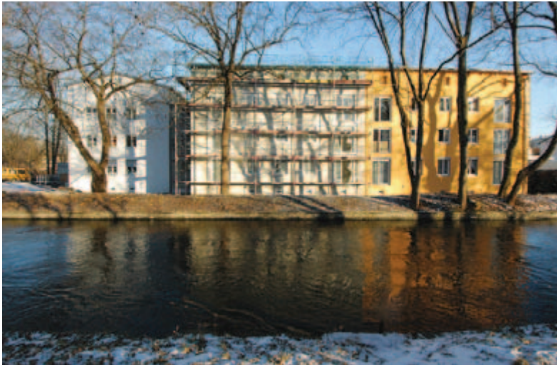
Augsburg, Am Herrenbach. Architekten: Büning und Kerschbaum, München
