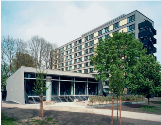
Sanierung Egon-Wiberg-Haus, München Studentenstadt Freimann Architekt: Christoph Maas, München
