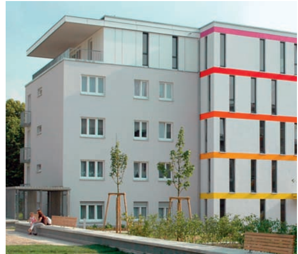
Regensburg, Pommernstraße. Experimenteller Wohnungsbau Architekten: Büning+Kerschbaum, München
