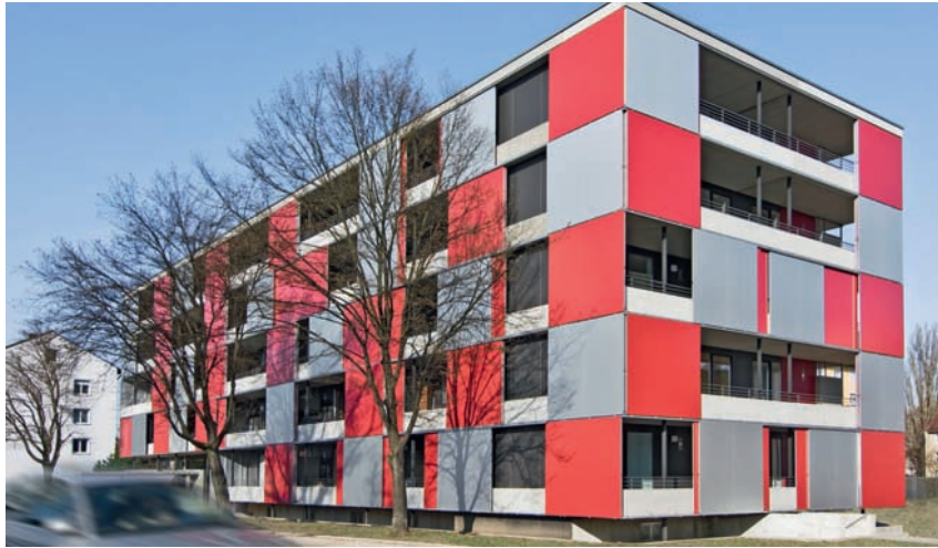
Wohnraumförderung: Wohnanlage für Senioren, Ingolstadt, Nürnberger Straße Architekten Beyer+Dier, Ingolstadt
