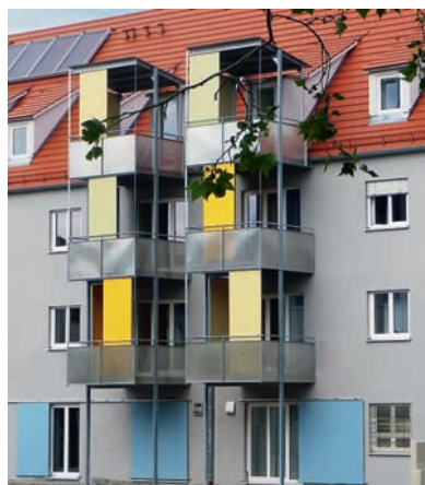
Schwabach, Konrad-Adenauer-Straße Experimenteller Wohnungsbau Architekten Rößner und Waldmann, Erlangen
