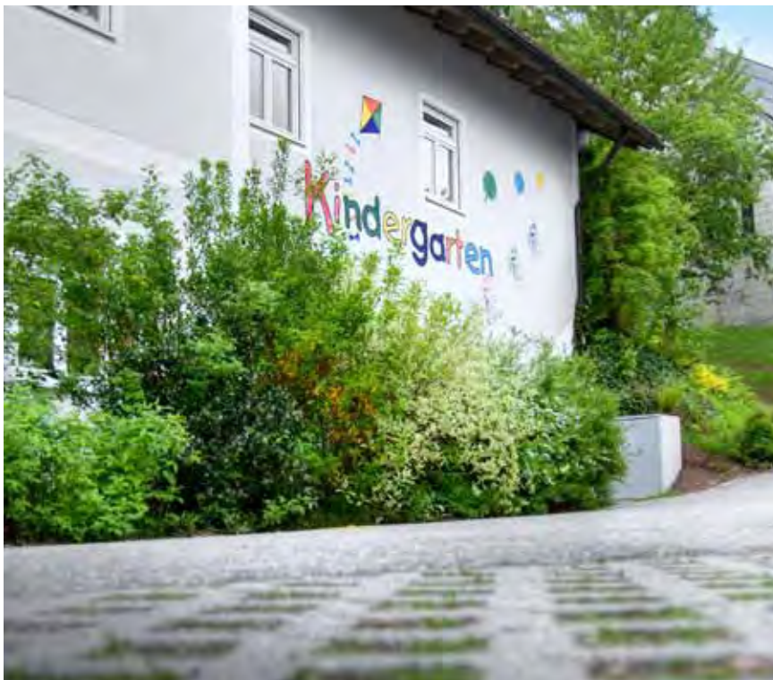
Förderung von kommunalen Einrichtungen: Umbau des Kindergartens in Sonnen mit Errichtung von 10 Kinderkrippenplätzen, finanziert mit dem Investkredit Kommunal Bayern
