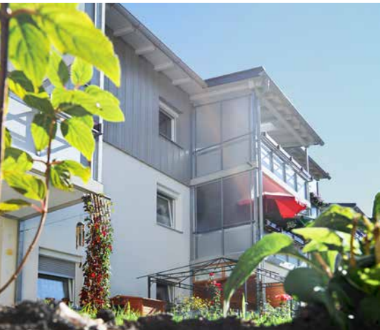
Förderung von Mietwohnraum: Modernisierung und Umbau der Wohnsiedlung Nagel-/Auerbergstraße in Hausham.
