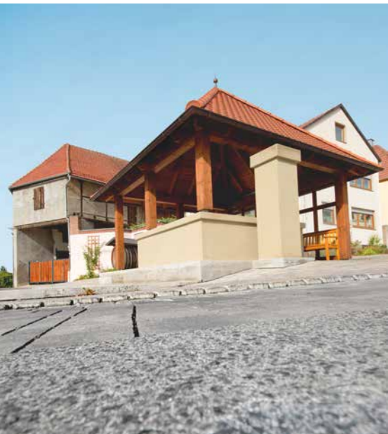
Förderung von kommunaler Infrastruktur: Neugestaltung des Dorfplatzes in Gädheim.
