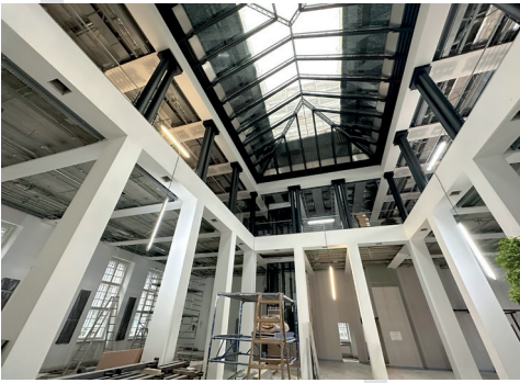
Baustelle mit Blick durch das Dach
