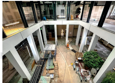
Baustelle im Erdgeschoss
