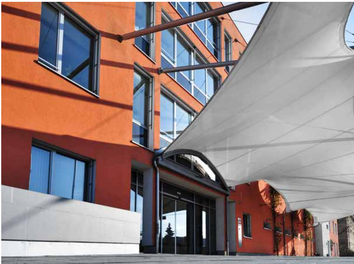
Förderung von Einrichtungen für Menschen mit Behinderung: Neubau der Münchner Förderschule in der Garmischer Straße.
